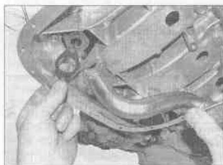
Рис. 13.6. Снятие маслоприемного патрубка и прокладки
