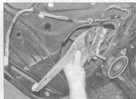
Рис. 15.14,б. ...и извлеките стеклоподъемник из проема в двери
