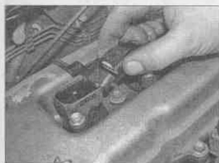
1 Проверьте надежность стыковки электрических разъемов катушек зажигания
