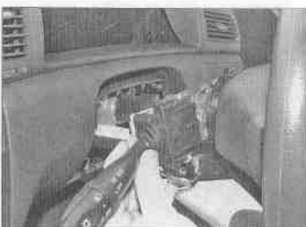
Рис. 4.4,б. ...и извлеките переключатель освещения из кронштейна
